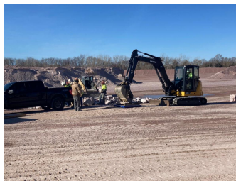
Clasificación de Rip Rap con empleados de LGE, el contratista y el USACE
